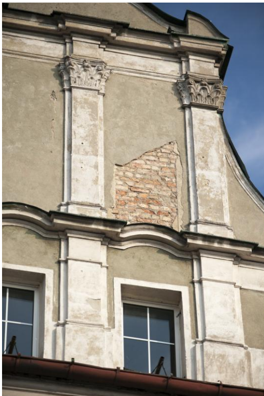
Okna PCV w szczycie od Starego Rynku
