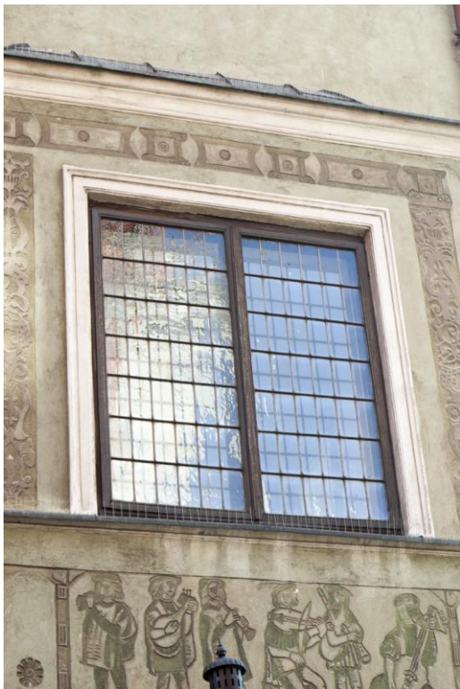
Okno wykuszu I. piętra
