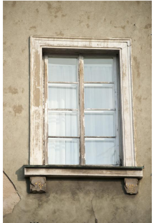
Okno I. piętra w elewacji od ul. Woźnej
