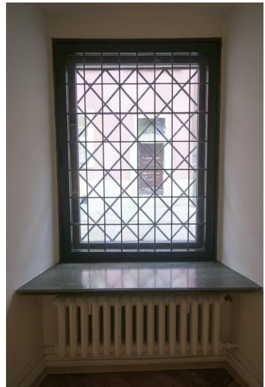
Okno na parterze od u. Woźnej
