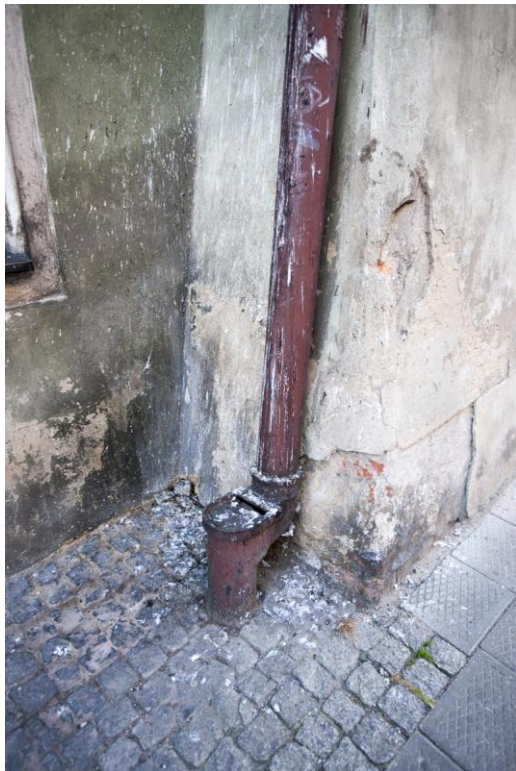
Degradacja partii cokołowej przy wpustach rur spustowych
