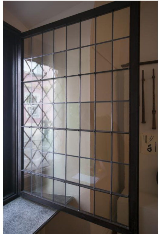
Szklenie w metalu okno parteru od ul. Woźnej
