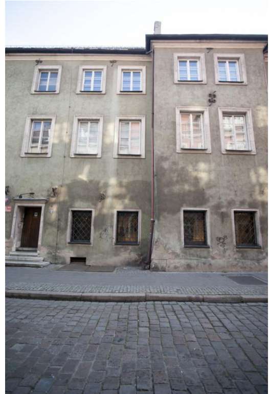
Elewacja północna od ul. Woźnej - ryzalit
