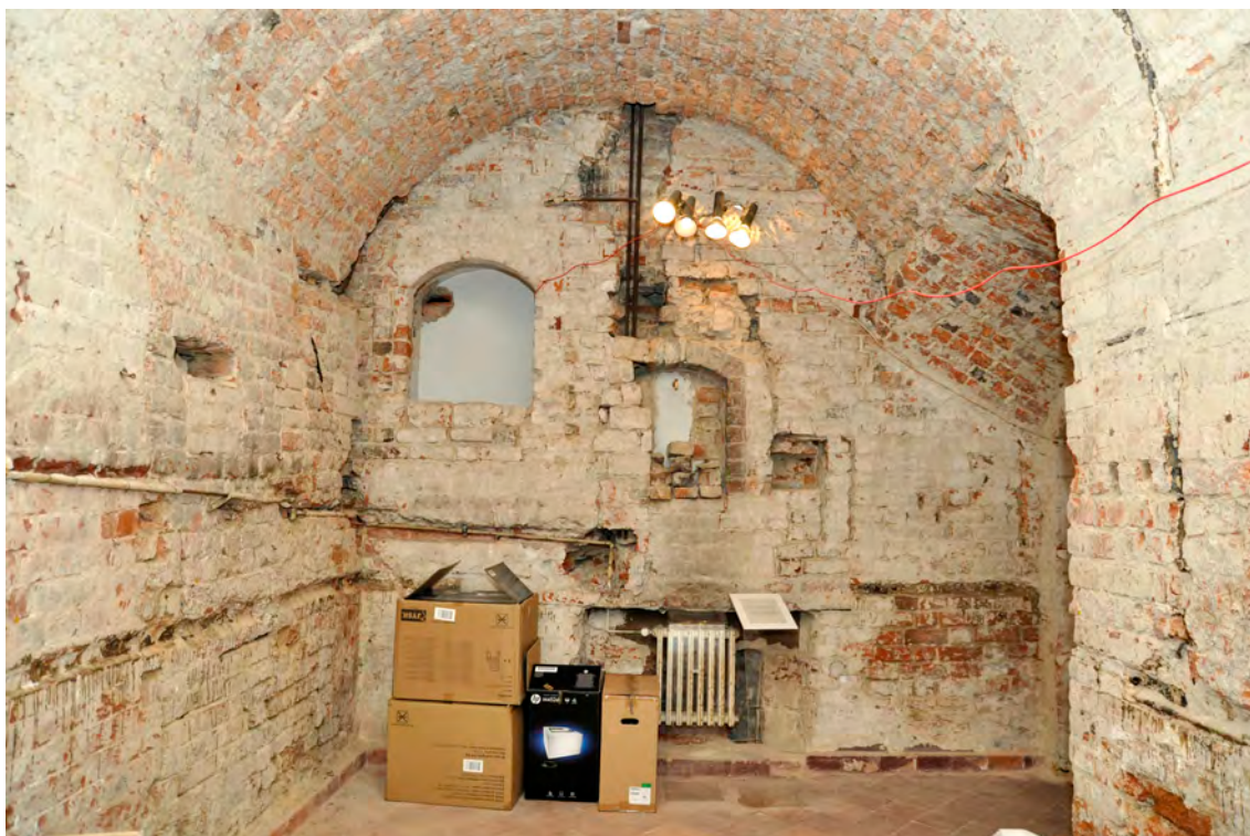
Fot. 21 Stary Ratusz w Poznaniu. Pomieszczenia ekspozycyjne piwnic. Pomieszczenie 109. Widoczne przemurowania wątków, ubytki i zniszczenia cegieł, przekucia i bruzdy instalacyjne, zabrudzenia powierzchni i pozostałości współczesnej zaprawy.
