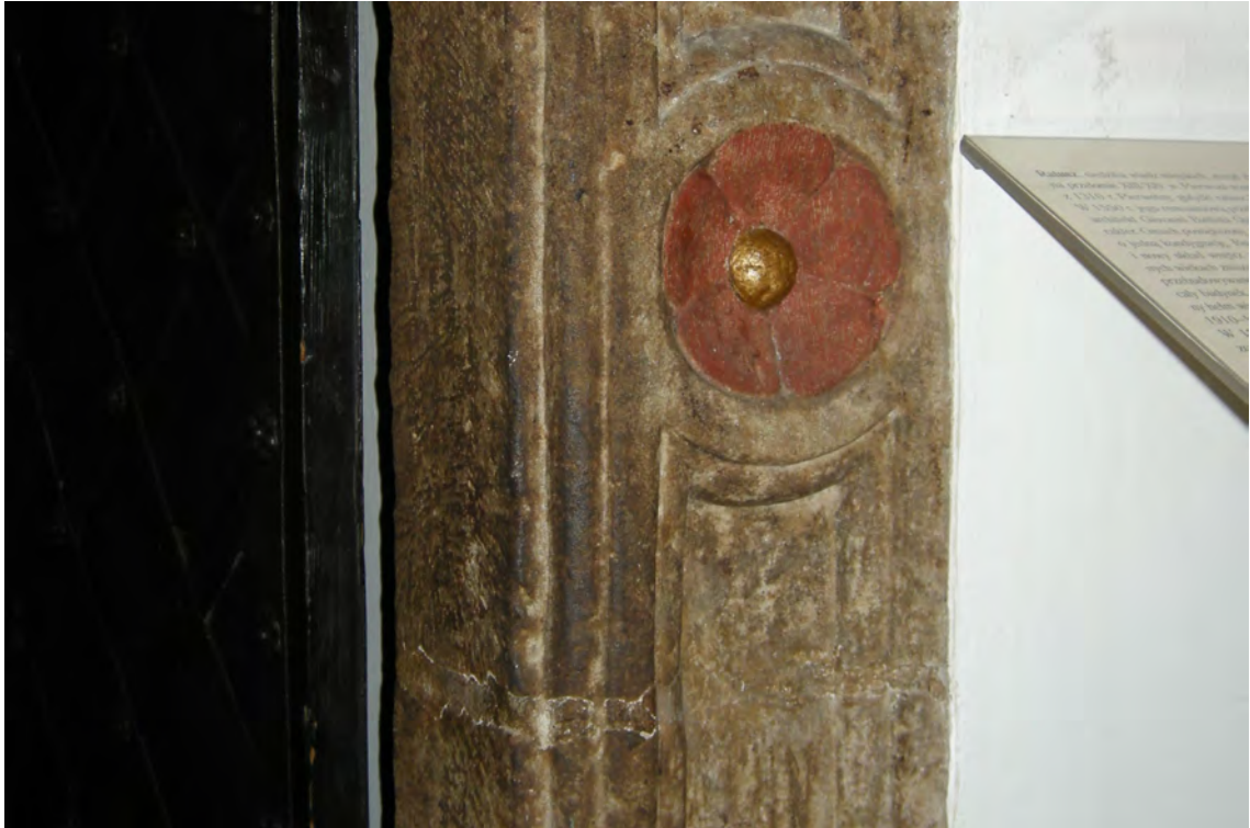
Fot. 1 Stary Ratusz w Poznaniu. Portal w pomieszczeniu 203 parteru. Widoczne zabrudzenie i zatłuszczenie krawędzi węgara.
