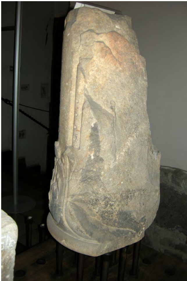
Fot. 43 Stary Ratusz w Poznaniu. Kamienne elementy ekspozycyjne. Dolny fragment trzonu kolumny z dziedzińca pałacu Górków, datowany na lata 40-te XVI w. (nr inw. MNP DA 347). Widoczne zabrudzenie, patyna oraz przebarwienia kamienia.
