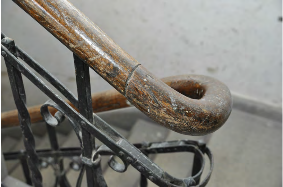
Fot. 25 Stary Ratusz w Poznaniu. Pomieszczenia piwnic. Pomieszczenie 110 – klatka schodowa. Balustrada z drewnianą poręczą. Widoczne ślady zużycia na powierzchni drewnianej poręczy – zabrudzenia, ubytki oraz przetarcia lakieru.
