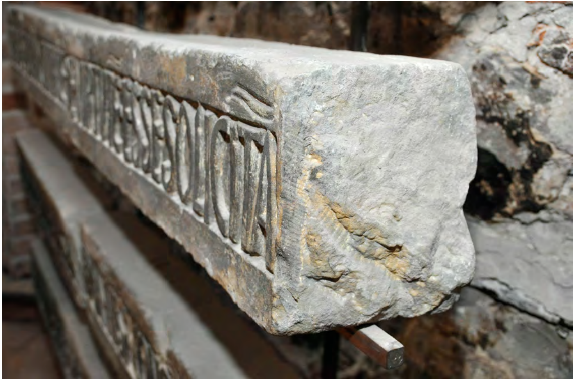
Fot. 39 Stary Ratusz w Poznaniu. Kamienne elementy ekspozycyjne. Nadproża okien pierwszego piętra Wagi Miejskiej z inskrypcjami (nr inw. MNP DA 5-8). Widoczne zabrudzenia, przebarwienia i uszkodzenia powierzchni.
