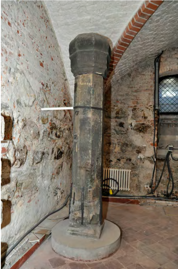
Fot. 35 Stary Ratusz w Poznaniu. Kamienne elementy ekspozycyjne. Pręgierz (nr inw. MNP P 505). Widoczna ciemna fałszywa patyna pochodzenia atmosferycznego, zaplamienia i przebarwienia kamienia oraz wyoblenia krawędzi na skutek erozji.
