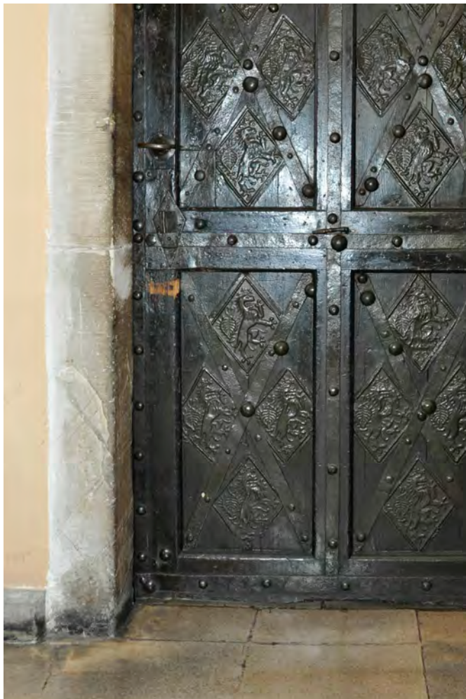
Fot. 1 Stary Ratusz w Poznaniu. Portal w pomieszczeniu 203 parteru. Widoczne zabrudzenie i zatłuszczenie krawędzi węgara.
